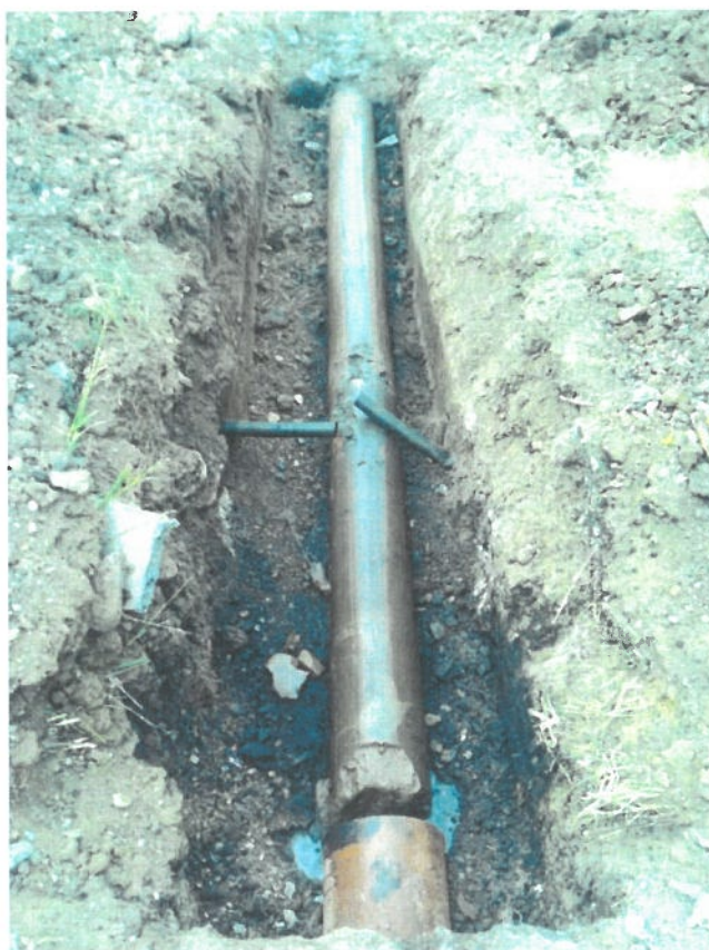
Foto 3 – Exemplificare - Extragerea pământului din tubul protector amplasat prin percuzie
