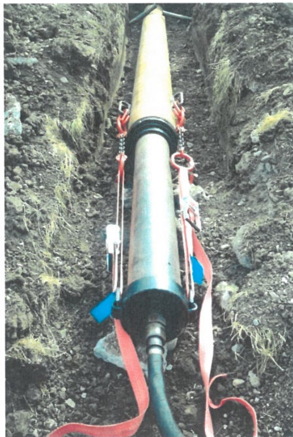
Foto 3 – Exemplificare - Extragerea pământului din tubul protector amplasat prin percuzie
