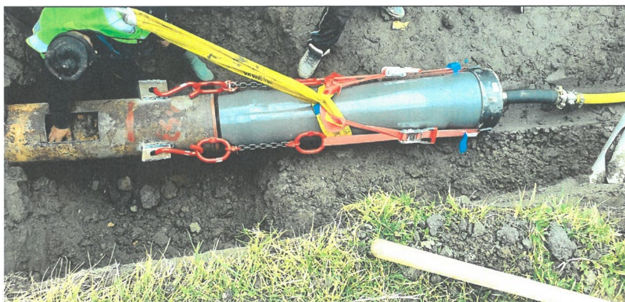
Foto 2 - Exemplificare ciocan de batere țevi montat pe tub protector
